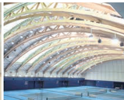
室内コート天井の梁は特殊な木製構造
